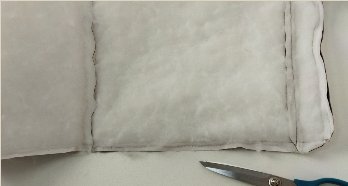
161. Утеплитель с припуска высечь, приупски на уголках высечь.
